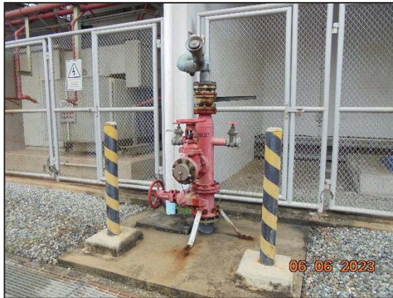
รูปที่ 3.37 Fire Hydrant
