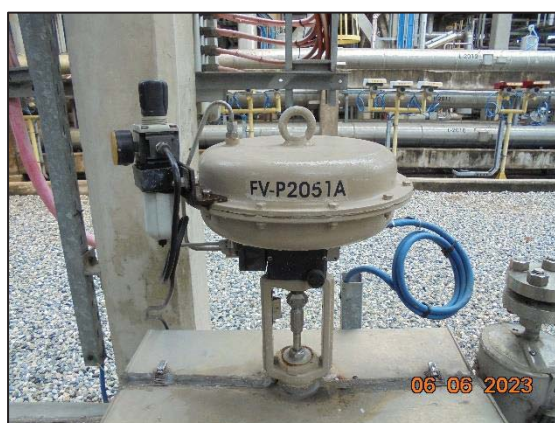
รูปที่ 3.56 Pressure Flow Control Valve
