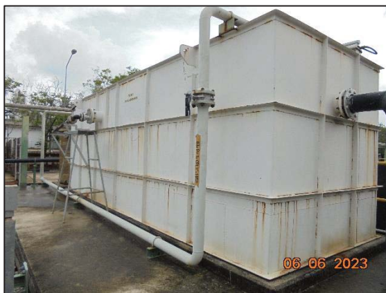
รูปที่ 3.15 Oil-water Separator (CPI)
