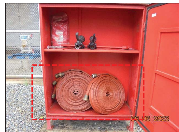
รูปที่ 3.36 สายน้ำดับเพลิง
