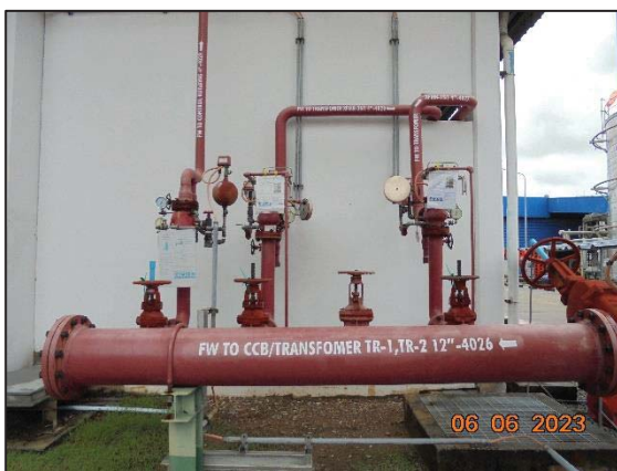
รูปที่ 3.33 ระบบท่อน้ำดับเพลิง
