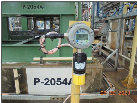
รูปที่ 3.31 EO Analyzer
