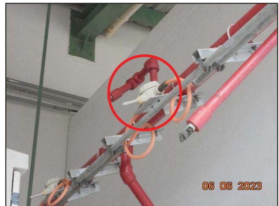
รูปที่ 3.32 Heat Detector
