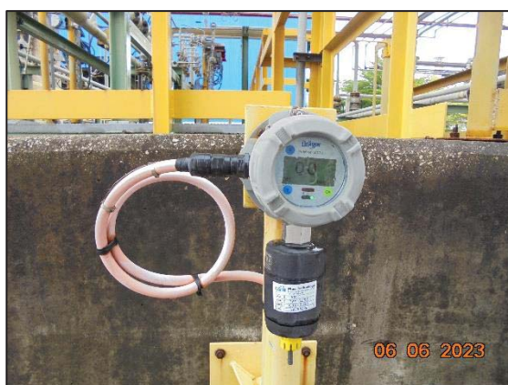
รูปที่ 3.51 Ammonia Gas Detector
