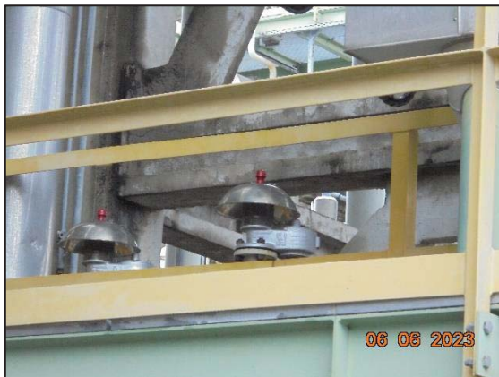
รูปที่ 3.47 Pressure Safety Valve
