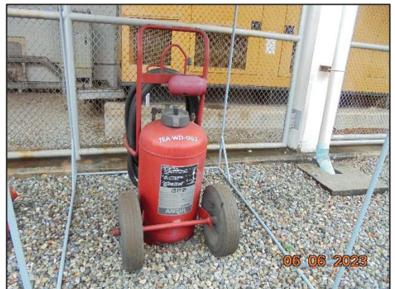
รูปที่ 3.39 ถัง Wheel Dry Chemical
